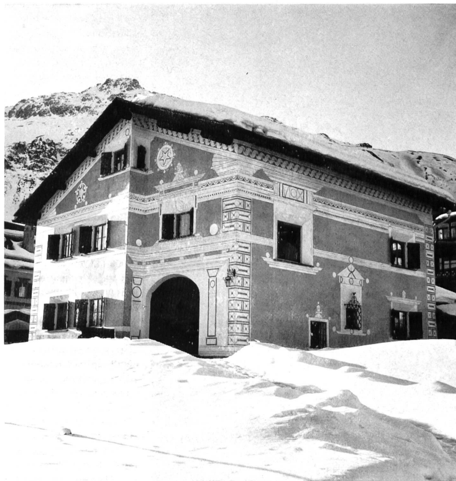
Bild 118 Im Engadinerstil errichtetes neues Haus in Samedan mit reicher Sgraffito-Ornamentik
