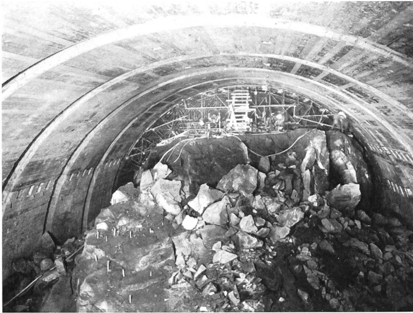
Bild 8 Kernausruch; im Hintergrund Schalung für den Gewölbescheitel.
