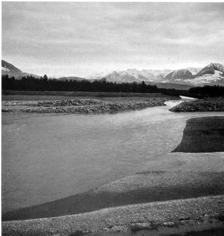
Bild 31 Mündung der Ill in den Rhein bei Niederwasser. Die als Folge der Regulierung eingetretene Absenkung der Rheinsohle ist deutlich erkennbar an der Niveaudifferenz zwischen den Wasserspiegeln der beiden Flüsse. Der ungefähr 3 m hohe Absturz der Ill ist mit einem Blockwurf gegen Erosion gesichert. (Photos H. Bertschinger Rorschach)
