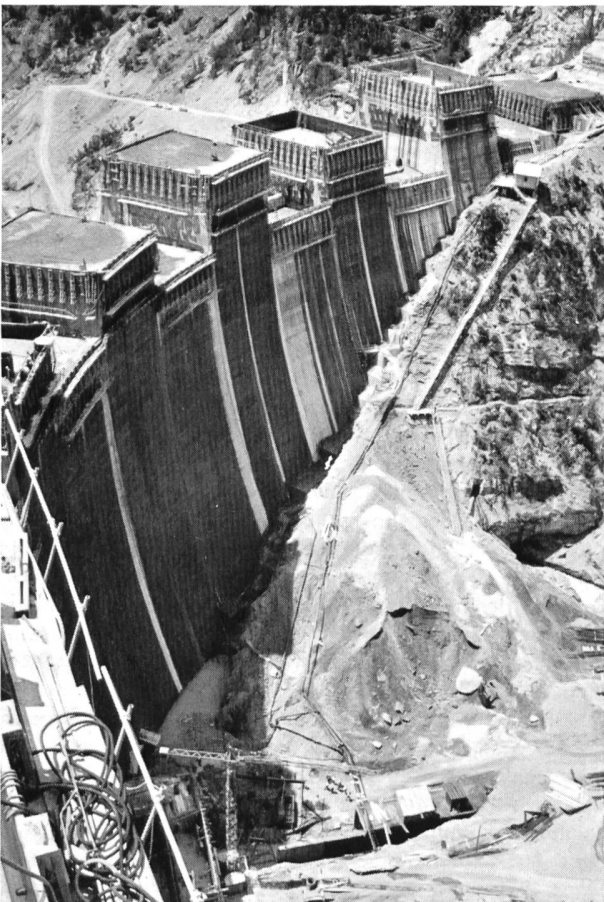
Bild 14 Talsperre Punt dal Gall, die am 1. Juli 1967 bereits 59 Prozent des gesamten Betonvolumens umfasste.
