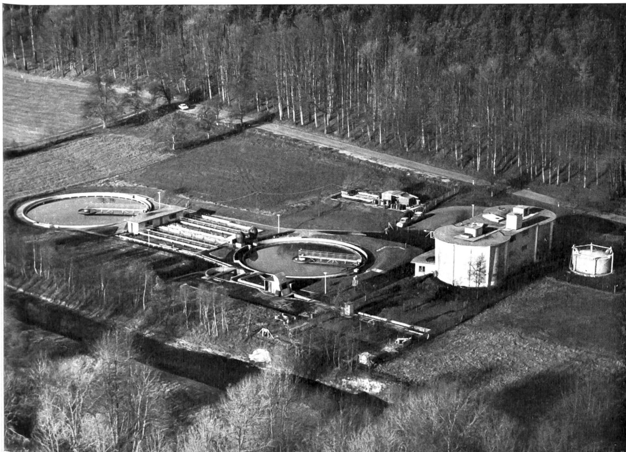
Kläranlage Uster (Kanton Zürich), eine der ersten Anlagen, welche die dritte Reinigungsstufe einführte. Erste Betriebsaufnahme 1956 mit mechanisch-biologischer Reinigung, seit 1960 Phosphatfällung nach dem Simultanverfahren. Flugbild Nov. 1963 Baudirektion Kanton Zürich
