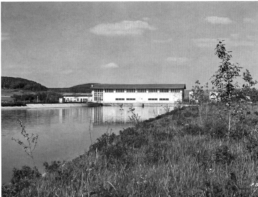
Bild 6 Maschinenhaus des Kanalkraftwerks Wildegg-Brugg, das 1952 in Betrieb genommene neueste Aarekraftwerk. (Photo Wolf-Benders Erben/NOK)
