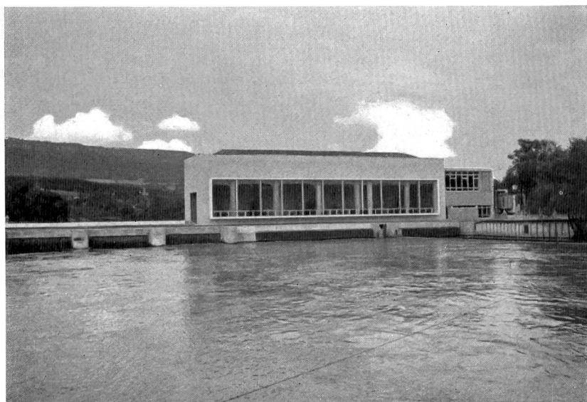
Bild 9 Das ebenfalls noch im Bereich der Stadt Aarau gelegene Aarekraftwerk Rüchlig der Juracement-Fabriken AG. Diese 1927/28 erstellte Anlage wurde 1961/62 teilweise erneuert, wobei hier in der Schweiz erstmals grössere Rohrturbinen zur Anwendung gelangten. Ansicht vom Oberwasser; rechts Maschinenhaus mit den ursprünglichen Einheiten, in der linken, wenig über den Wasserspiegel aufragenden Konstruktion sind die neuen Rohrturbinen installiert. (Photo G. A. Töndury)
