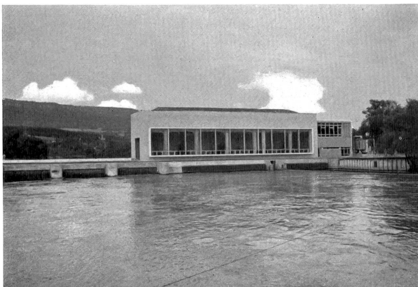
Bild 9 Das ebenfalls noch im Bereich der Stadt Aarau gelegene Aarekraftwerk Rüchlig der Juracement-Fabriken AG. Diese 1927/28 erstellte Anlage wurde 1961/62 teilweise erneuert, wobei hier in der Schweiz erstmals grössere Rohrturbinen zur Anwendung gelangten. Ansicht vom Oberwasser; rechts Maschinenhaus mit den ursprünglichen Einheiten, in der linken, wenig über den Wasserspiegel aufragenden Konstruktion sind die neuen Rohrturbinen installiert. (Photo G. A. Töndury)
