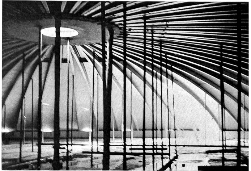
Bild 12 Bauphase eines Grosstanks.
