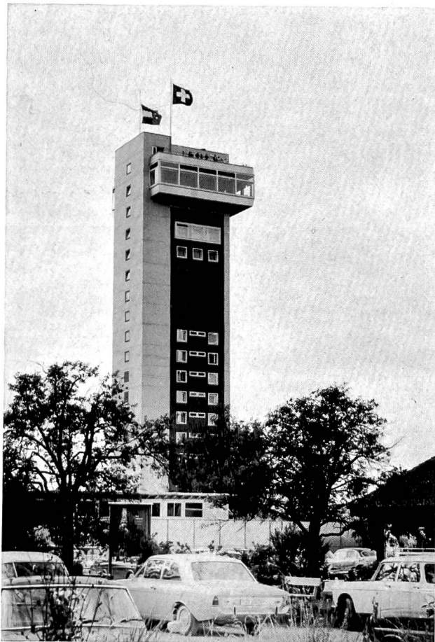
Bild 4 Turmhotel mit Wasserspeicher in Zurzach.
