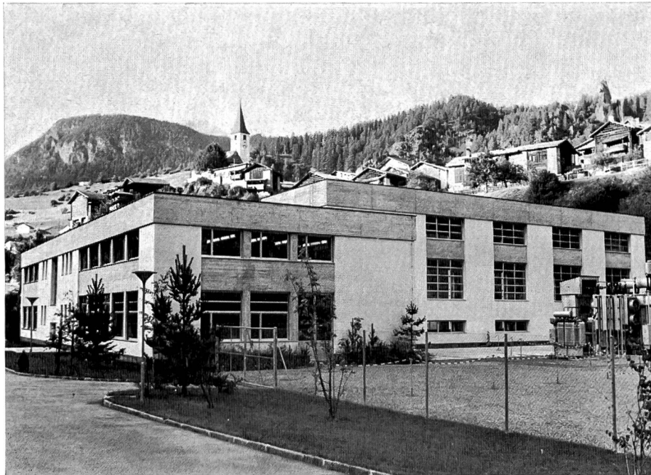
Bild 7 Zentrale Filisur und Dorfpartie
