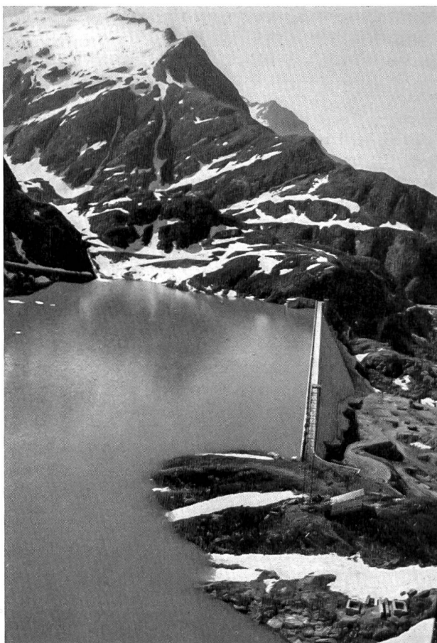
Bild 11 Tiefblick aus der 10 t-Seilbahn Robiei-Cortino auf Talsperre und Stausee Robiei.
