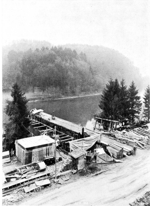
Bild 12 Baugrube für Kühlwasserrückgabe
