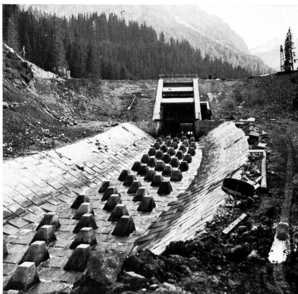
Bild 4 Ablaufgerinne mit Einbauten für Energievernichtung
