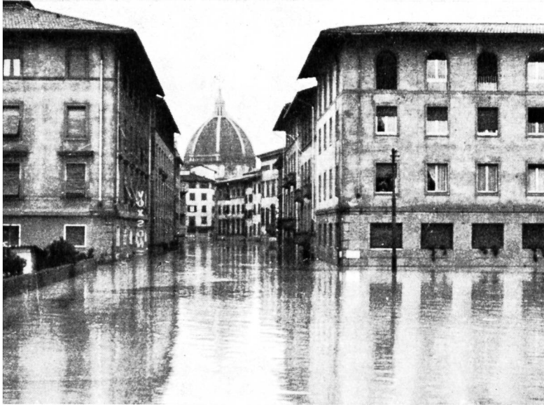
Bild 10 Mehr als die Hälfte der Stadt Florenz wurde beim Hochwasser vom 4./5. November 1966 überschwemmt. Im Hintergrund die Domkuppel; man beachte das Strassenschild am Haus rechts, an dem ersichtlich ist, dass das Erdgeschoss vollständig überflutet wurde.
