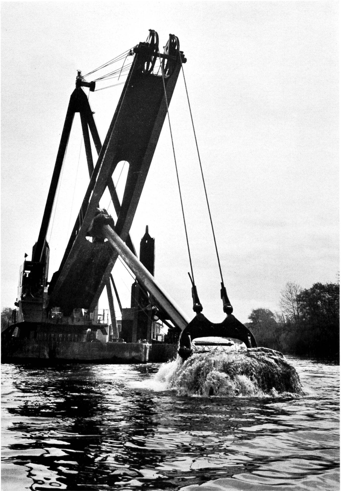
Bild 1 Mit dem Einsatz modernster, für Europa erstmaliger Installationen wurde das Werk grosszügig angepackt: Der Manitowoc-Schwimmbagger.
