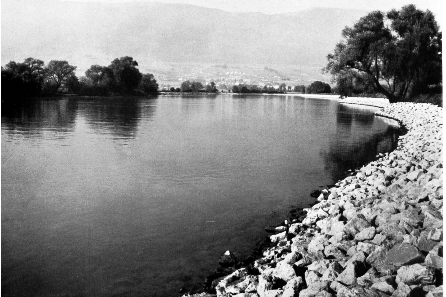
Bild 7 Mäanderstrecke der Aare, gesicherte Aussenseite der Krümmung von Arch.
