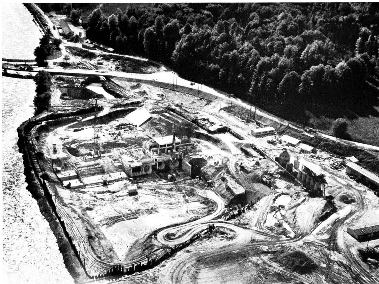
Bild 6 Flugaufnahme der Baustelle für Maschinenhaus und Wehr. Bauzustand Juni 1968.
