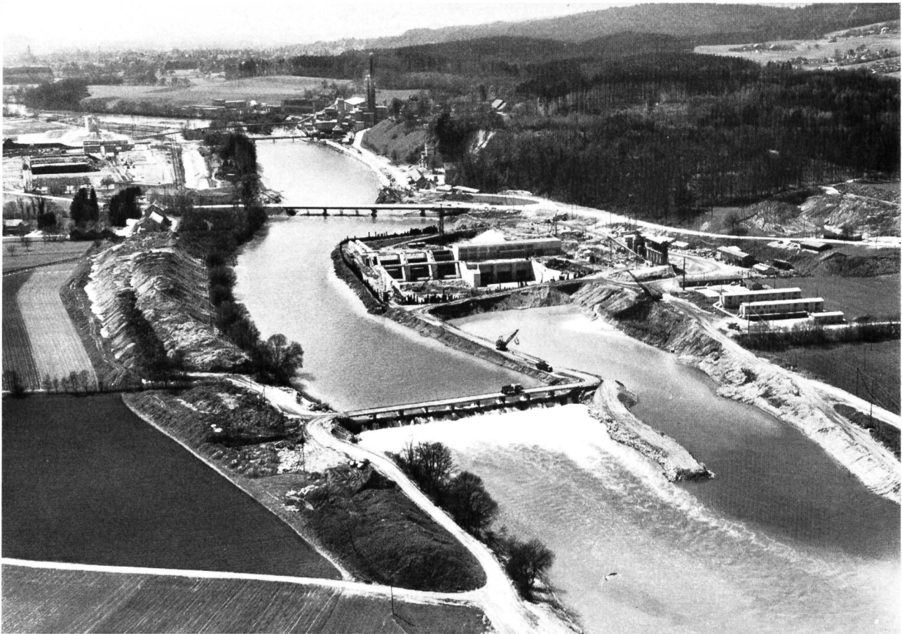
Bild 13 Flugaufnahme der Baustelle für Maschinenhaus und Wehr. Im Vordergrund das provisorische Absturzbauwerk, im Hintergrund die Cellulosefabrik Attisholz. Bauzustand Anfang Mai 1969, ca. zwei Wochen vor dem Fluten der Baugrube.
