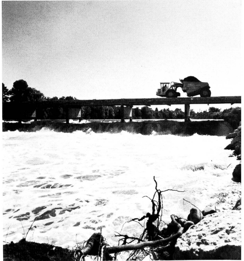
Bild 11 Provisorisches Absturzbauwerk in der Aare, kombiniert mit Dienstbrücke.
