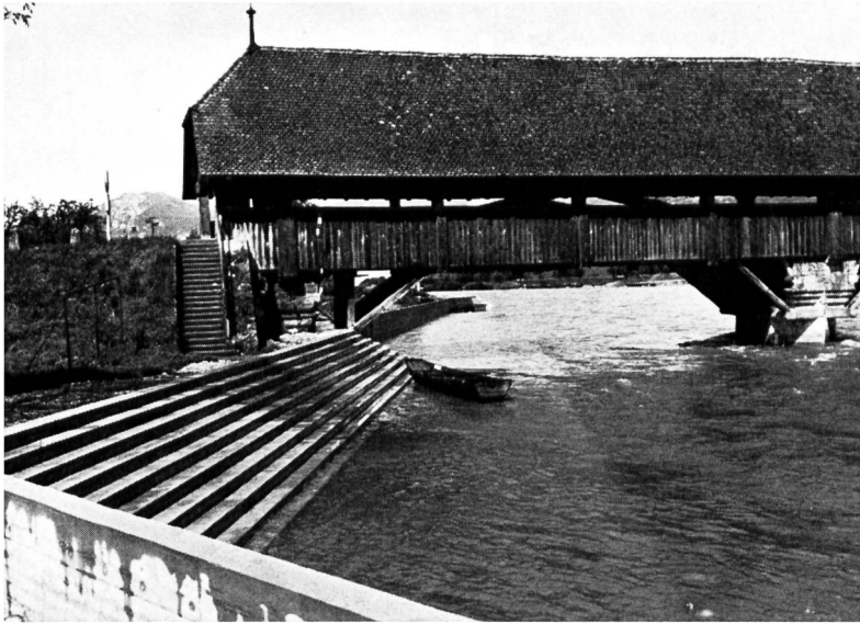
Bild 2 Holzbrücke bei Wangen an der Aare; neue Uferausbildung am rechten Widerlager.
