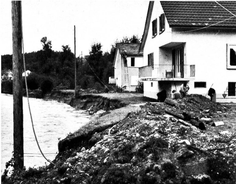
Bild 2 Murg in Matzingen. Wiederherstellungsarbeiten an der Auslenkkurve.
