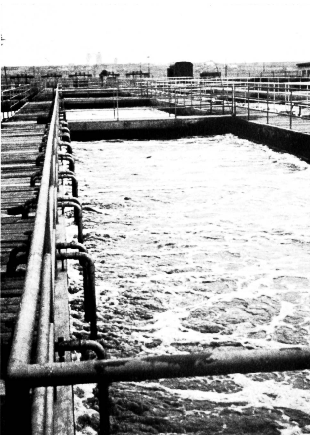
Bild 9 Belüftungsbecken.
