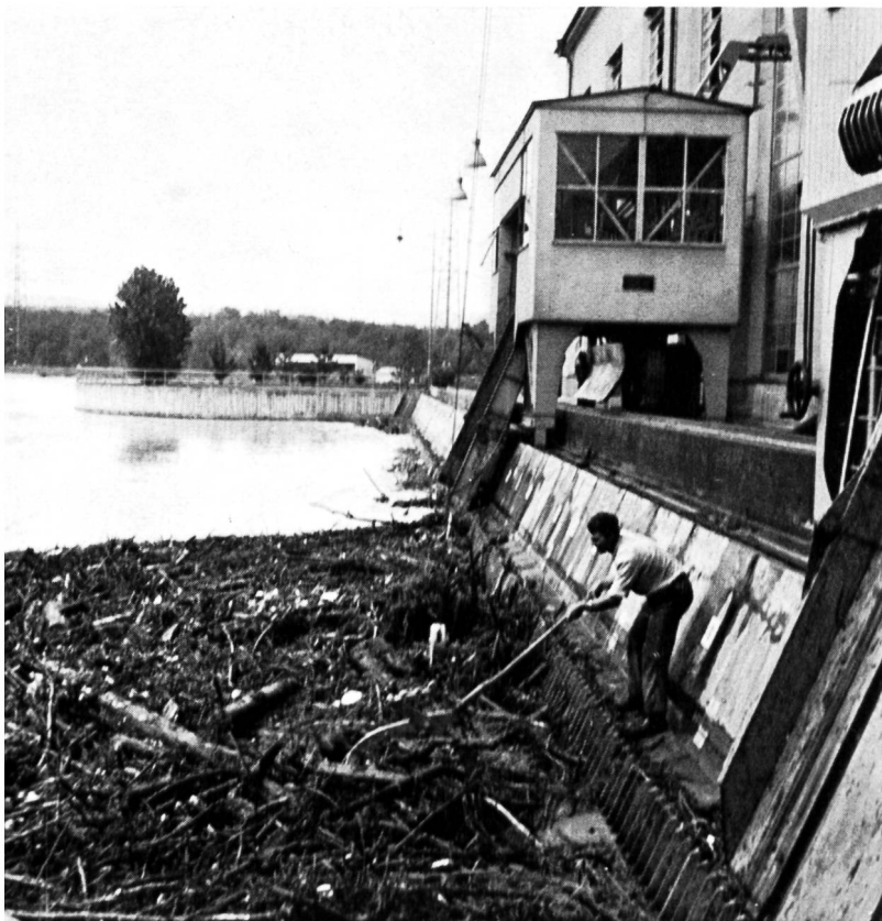
Bild 3 Geschwemmselteppich vor dem Kraftwerk Klingnau am 22. September 1968; insgesamt wurden bei diesem Hochwasser 1300 m 3 Rechengut gehoben.
