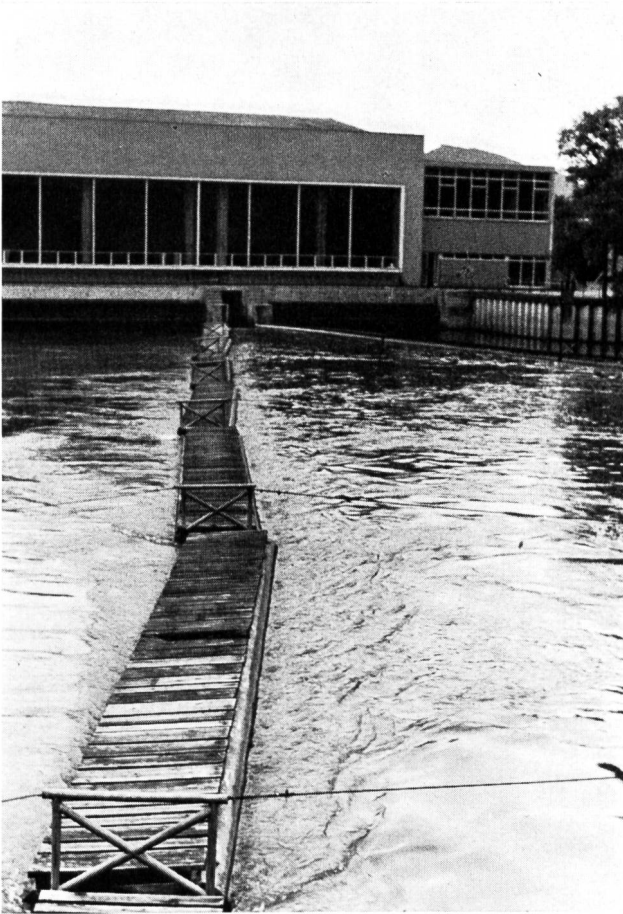
Bild 4 Schwimmbalken vor den Rechen des Kraftwerkes Aarau-Rüchlig; das Treibzeug wird in einen Spülkanal, der ins Unterwasser ausmündet, abgelenkt.
