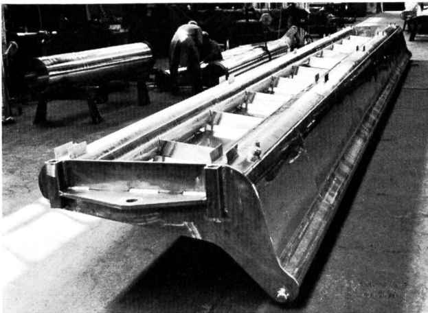
Bild 5 Der Aluminiumschwimmkörper eines Schwimmbalkenelementes des Kraftwerkes Aarau-Rüchlig.
