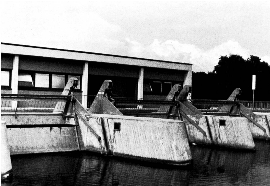
Bild 7 Ortsfeste Rechenreinigungsmaschine des Kraftwerkes Aarberg, Konstruktion Fäh.
