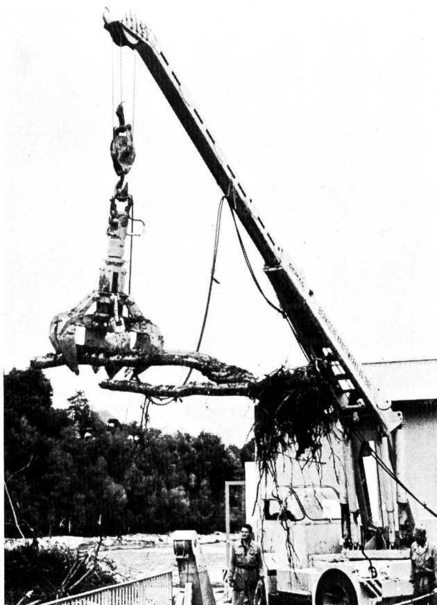
Bild 9 Pneukran mit hydraulischem Mehrzangengreifer im Einsatz beim Kraftwerk Niederried.
