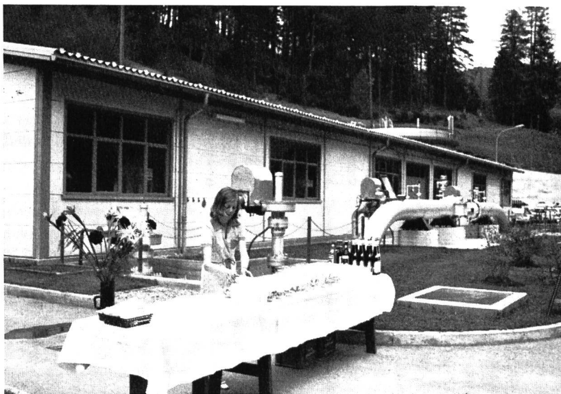
Bild 5 Teilansicht der Druckreduzier-Station Rongellen
