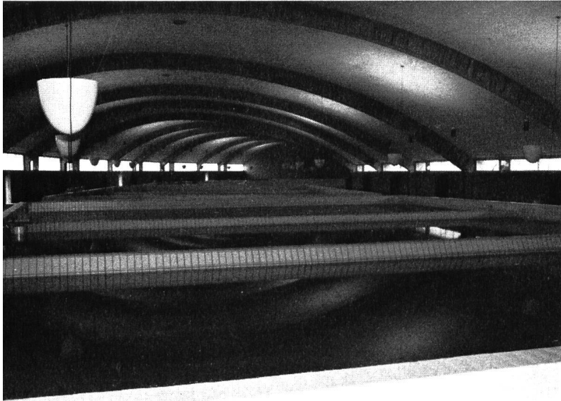
Bild 3 Blick in die etwa 170 m lange neue Halle der Schnellfilteranlage
