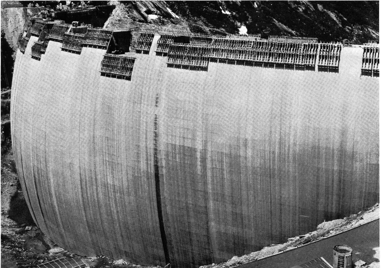
Staumauer Sta. Maria
