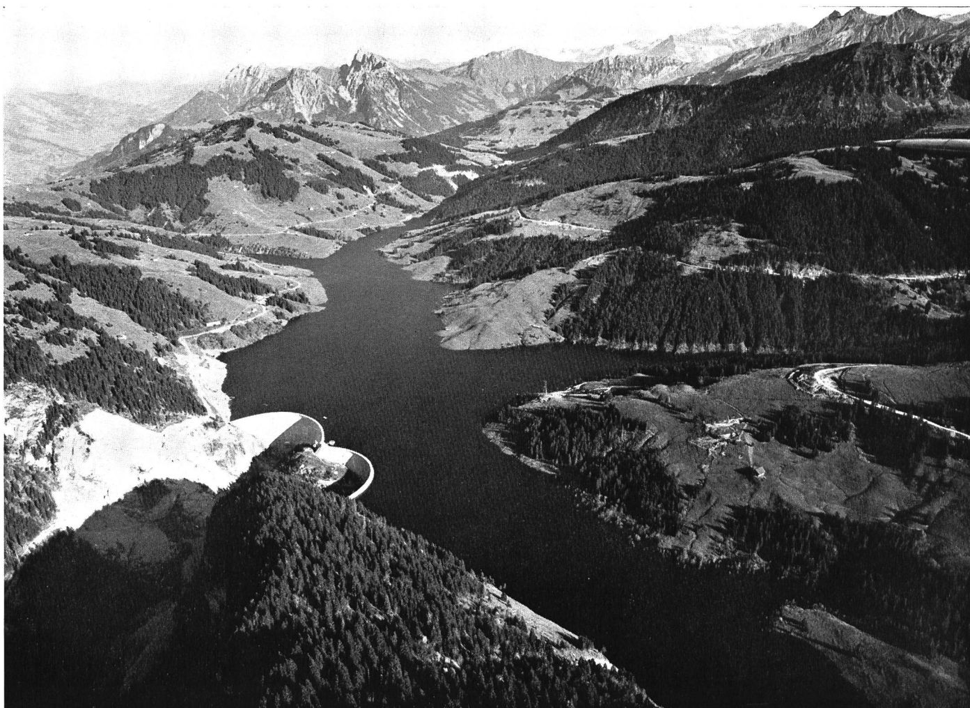
Vue aérienne du Barrage de l'Hongrin
