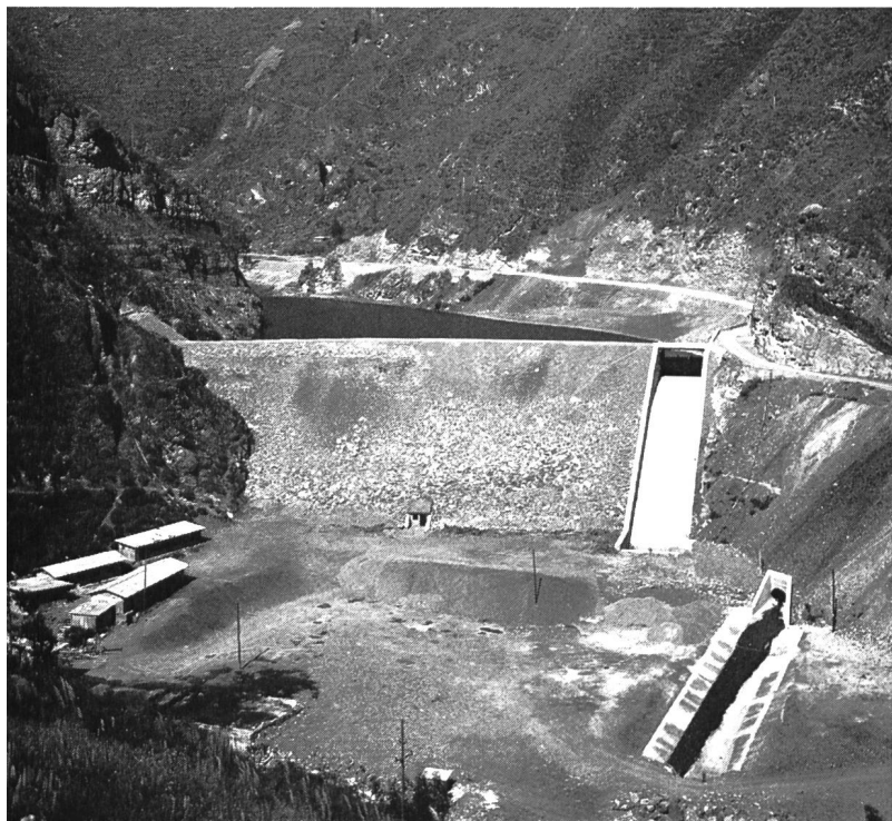
Bild 2 Erdamm Sheque, 38,6 m hoch, 125 m lang, im Rio Canchis in Peru
