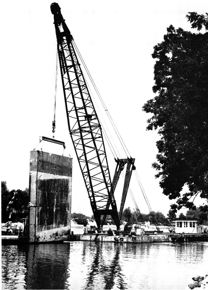
Bauarbeiten der II. JGK am Nidau-Büren-Kanal
