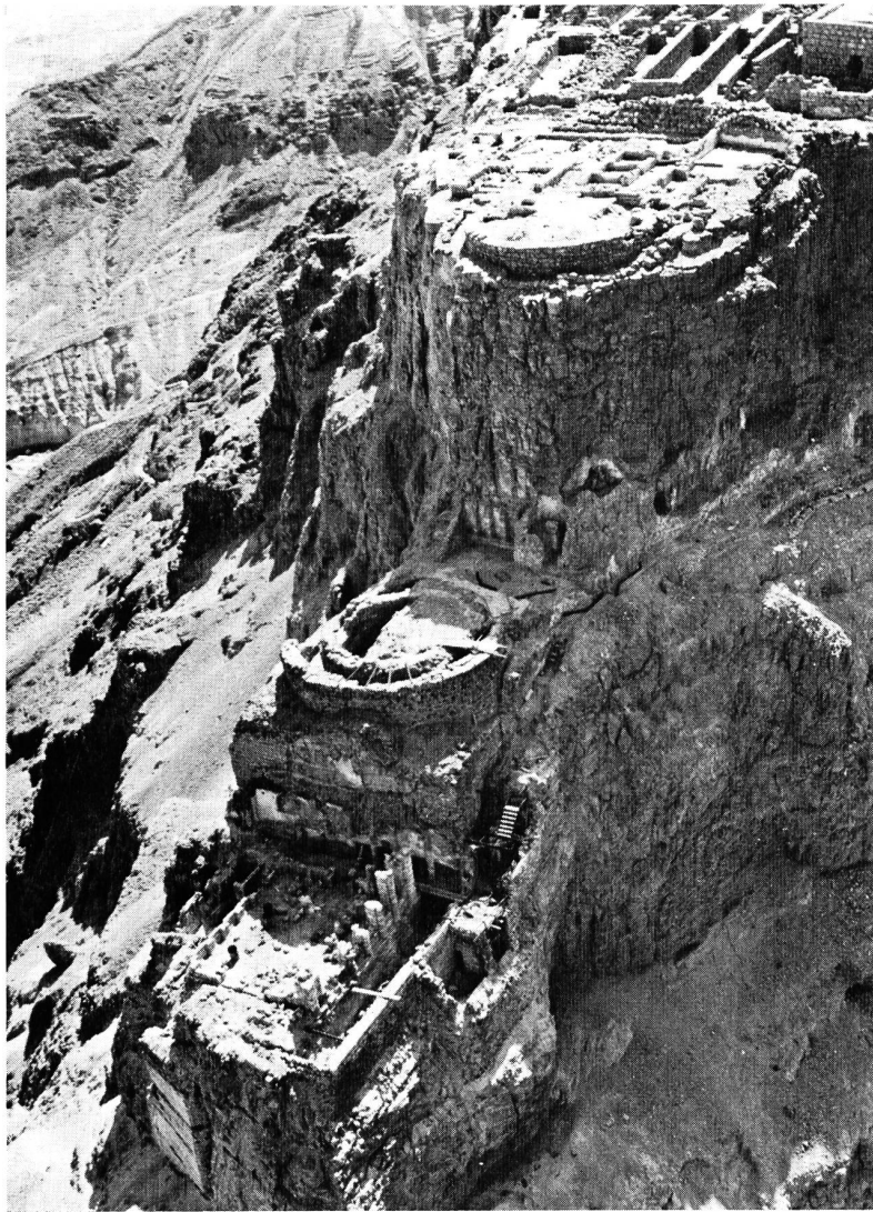
Bild 5 Nordpalast von Masada. Die mittlere Terrasse zeigt den Taubrunnen mit den konzentrischen Mauerringen, der zur Speisung des Privatbades von König Herodes diente; der Zugang zu diesem Privatbad ist auf der untersten Terrasse erkennbar. Auf dem obersten Plateau Ruinen von Wohntrakt, Therme und Vorratskammern
