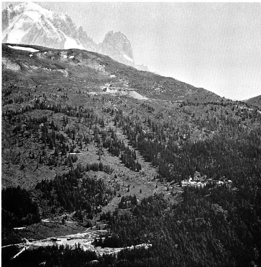
Wasserschloss (obere Bildhälfte) und Ausgleichbecken Les Esserts (im Bild unten links) der Zuleitung Ost; im Hintergrund Aiguille Verte und Aiguille du Dru (Photo: M. Darbellay, Martigny)
