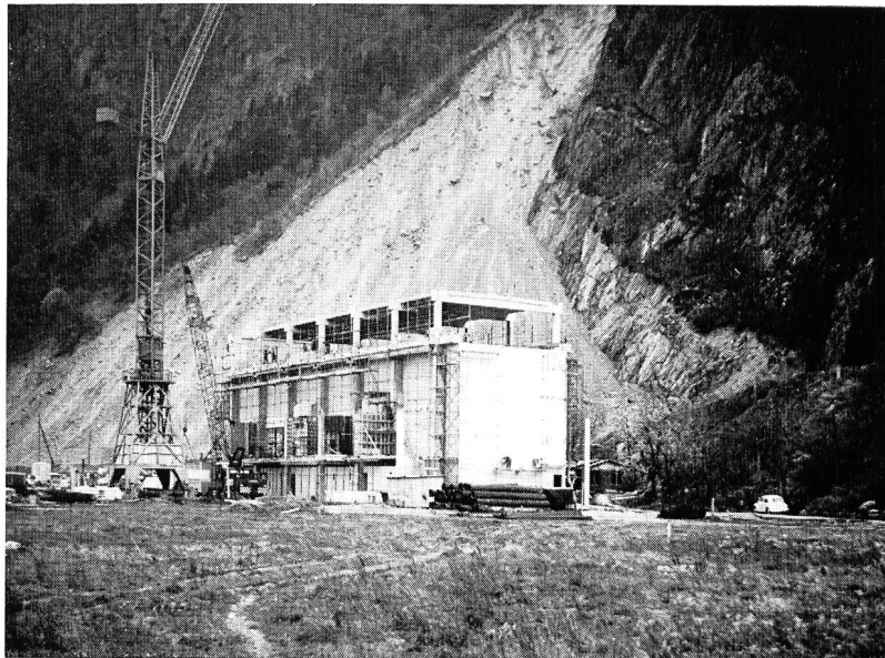
Zentrale La Bâtiâz am Fusse der rechts sichtbaren Felswand; Aufnahme vom 15. April 1971 (Photo: M. Darbellay, Martigny)
