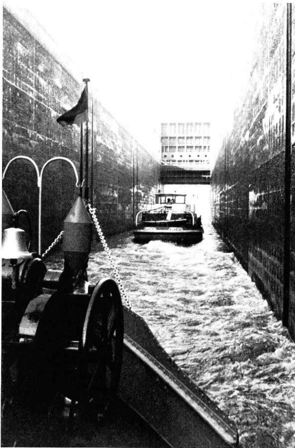
Bild 6 In der grossen und tiefen Schifffahrtsschleuse des Rheinkraftwerkes Marckholsheim der EdF
