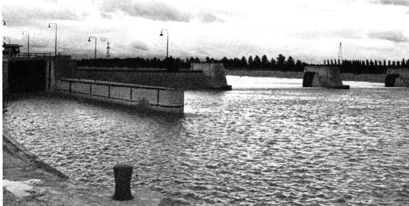
Bild 2 Landeskulturwehr für den Aufstau des «Restrheins» südlich von Breisach
