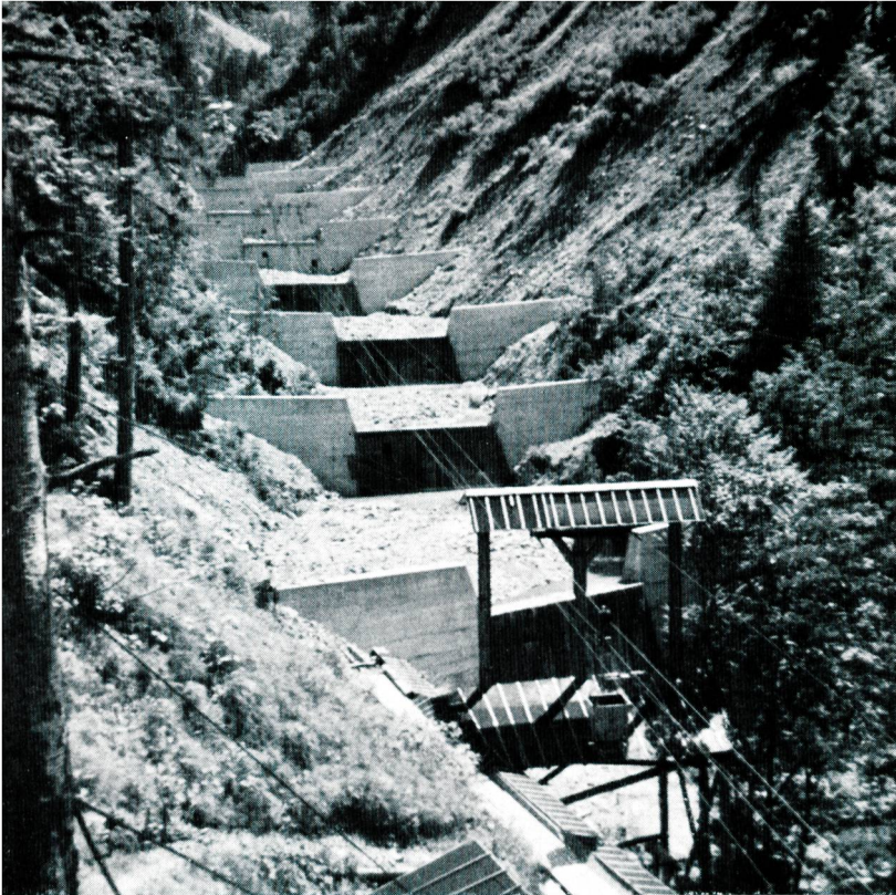
Bild 9 Sperrentreppe im Durnageltobel.
