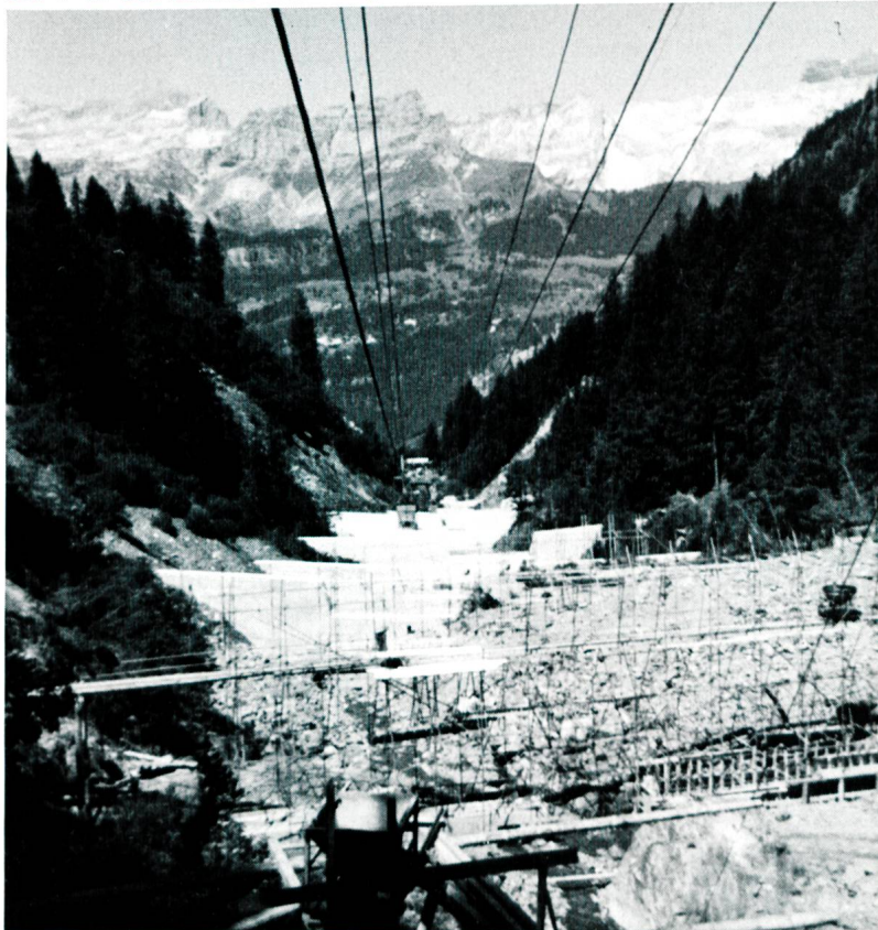
Bild 4 Im Bau stehende Wildbachsperren im oberen Durnageltobel.
