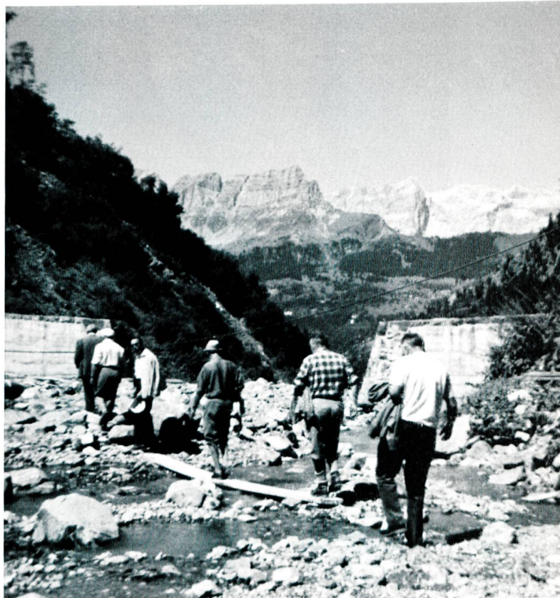
Bild 7 Abstieg von Sperre zu Sperre.
