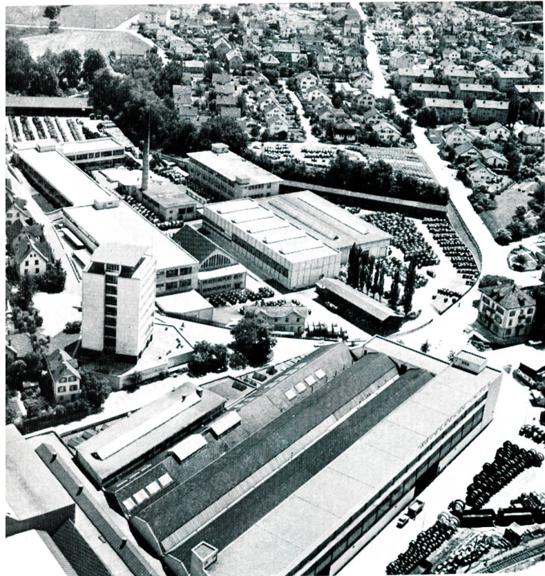
Bild 1 Gesamtansicht des Fabrikkomplexes der Kabelwerke. Typisch für dieses Unternehmen sind die ausgedehnten Rollenlager auf dem Betriebsareal (Foto F. Engesser).
