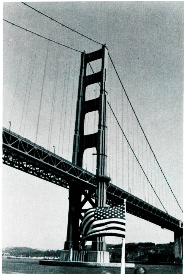
Bild 1 Hoher Brückenpfeiler der Goldengate Bridge, dem Wahrzeichen von San Francisco.
