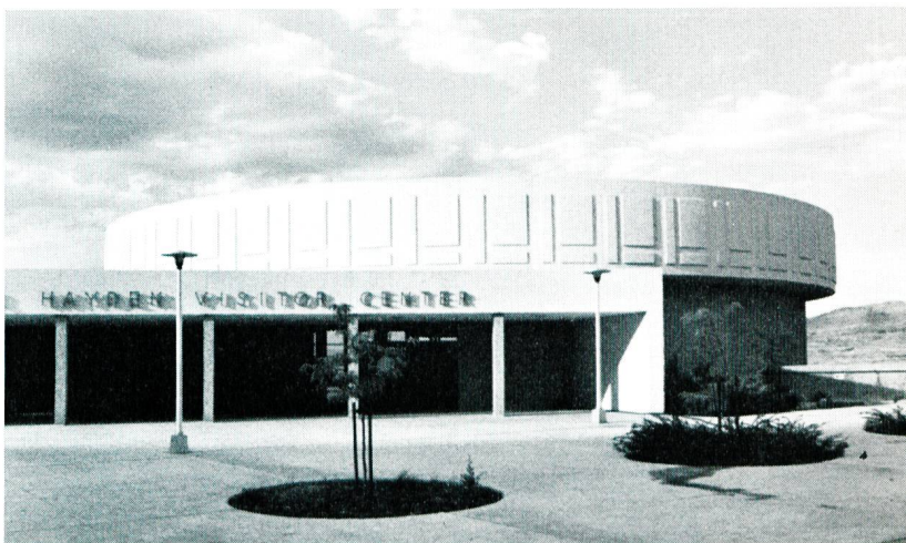
▼ Bild 34 Empfangsbauwerk für den Glen Canyon Dam.
