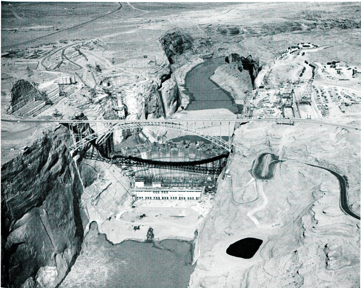
Bild 28 Flugaufnahme vom 2. Februar 1962 aus der Bauzeit des Glen Canyon Dam.
