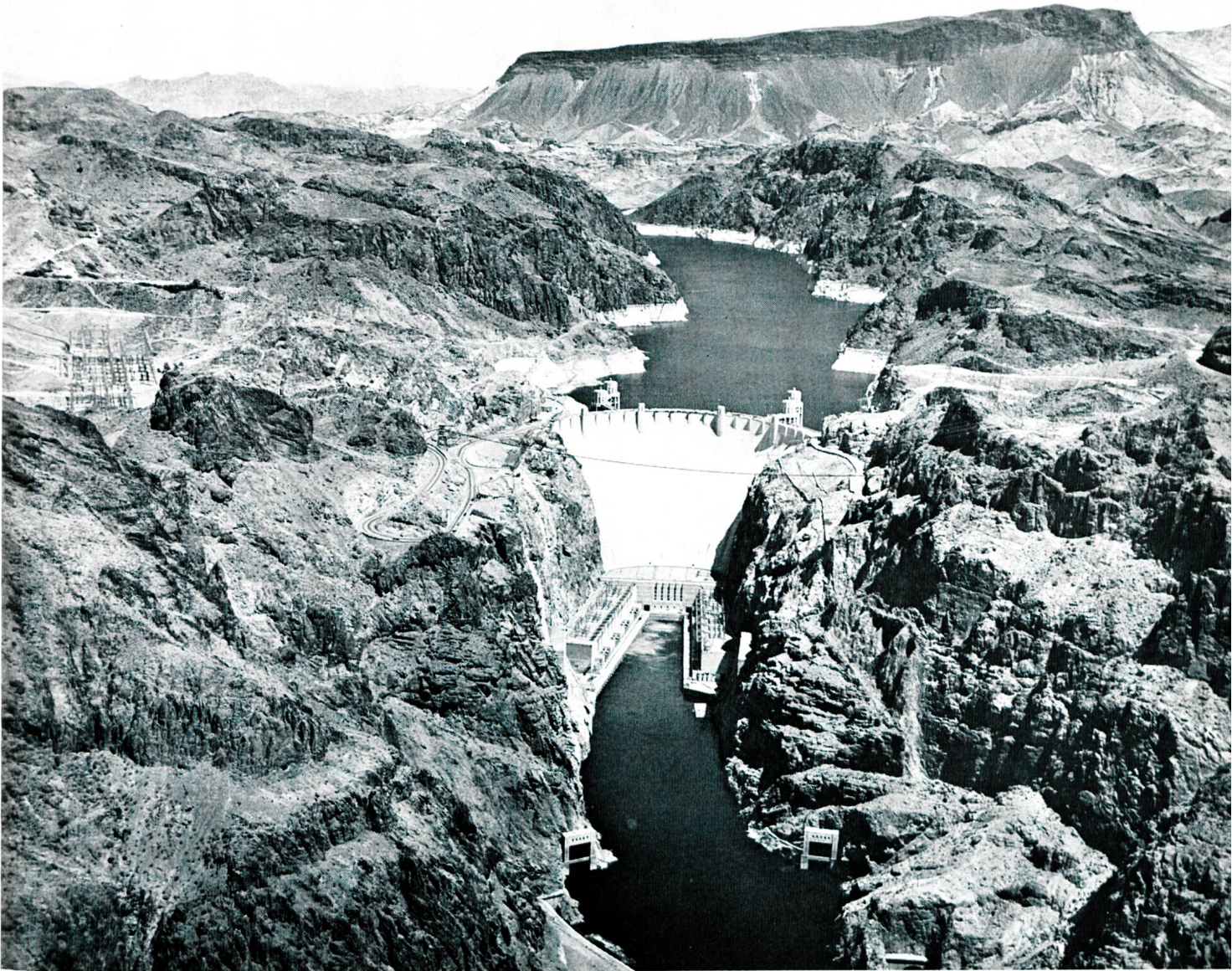
Bild 11 Flugaufnahme auf die von roten Felsen gebildete tiefe Colorado-Schlucht und die 1936 fertiggestellte Hoover-Talsperre. Zur Zeit der Errichtung handelte es sich bei weitem um die höchste Talsperre der Welt; am Fusse der Talsperre sind an beiden Felsflanken die grossen Kraftwerke sichtbar, eines auf Territorium des Staates Nevada, das andere auf Gebiet des Staates Arizona. Im Bilde links der Talsperrenkrone ist die nach Las Vegas führende Zufahrtsstrasse ersichtlich und ganz links im Bild die grosse Schaltanlage.
