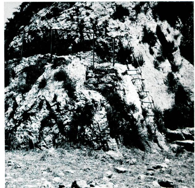
Bild 8 Anfangsstrecke des Felseinschnittes im Vallon de Baume für den römischen Aquädukt nach Glanum (Saint-Rémy); darunter links und in Bildmitte (mit Mauerwerk gefüllt) zwei der Fundamentnischen für das Gerüst, auf dem der Aquädukt in einer ersten Phase geführt worden war.
