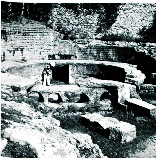
Bild 4 Das «Castellum divisorium aquae» in Nîmes; im Hintergrund der Einlauf des Aquäduktes in das Rundbecken von etwa 30 m 3 Nutzinhalt, vorn einige der zehn Austritte zu den fünf doppelsträngigen Hauptverteilungen.
