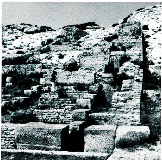
Bild 5 Oestliche Hälfte des spätrömischen Mühlenkomplexes von Barbegal, 8 km nordöstlich von Arles; ganz oben am Horizont der Felseinschnitt zwischen Triebwasserzuleitung und Verteilbecken; rechts drei der in Stufen untereinander angeordneten Wasserradkammern, an die links die Mahlstuben anschlossen.
