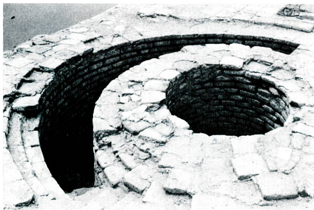
Bild 13 Wendeltreppe und Zentralschacht im Entnahmeturm der Sperre.
