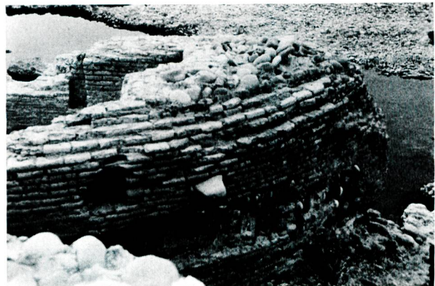
Bild 31 Schiffsbugförmige Hohlpfeiler des Wehres in Disful.
