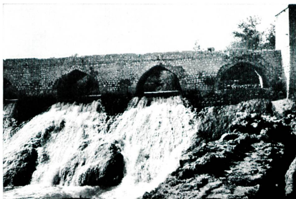
Bild 5 Strassenbrücke auf der überströmten Krone der Staumauer Bend-e-Emir.
