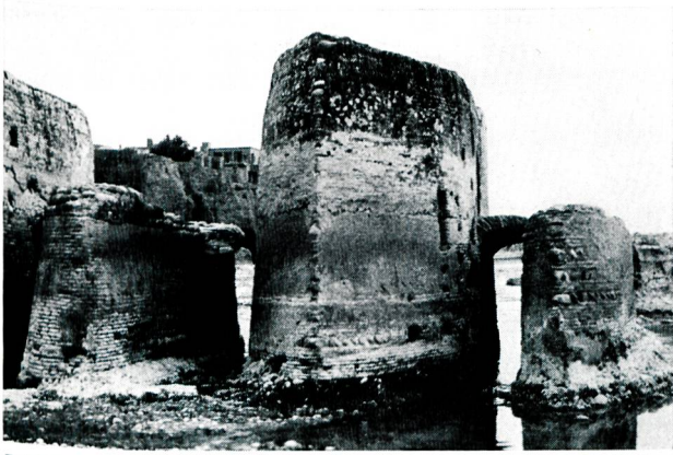
Bild 29 Wechsel von spitzbogenförmigen Mühlen- und Wehrpfeilern am Dez-Wehr in Disful.
