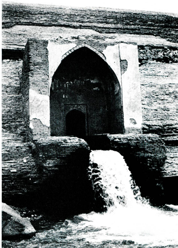
Bild 15 Ornamentales Portal für die Entnahme an der Gulestan-Sperre.
