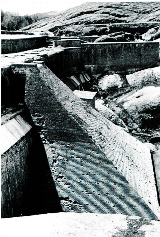
Bild 11 Stützpyramide der Fehrman-Sperre.
