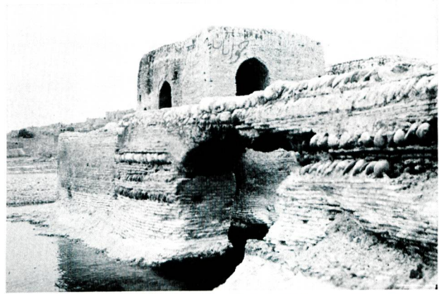
Bild 30 Römische Mauertechnik am Wehr in Disful.
