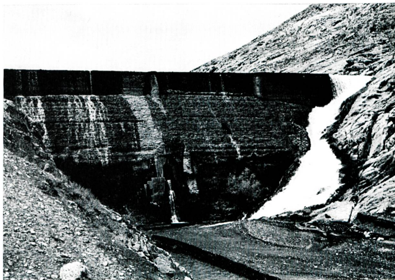
Bild 8 Gewichtsstaumauer Torogh bei Mesched.
