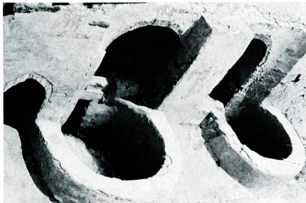
Bild 39 Restauriertes Kraftwerk in der Gärgär-Schlucht (in Betrieb!)
