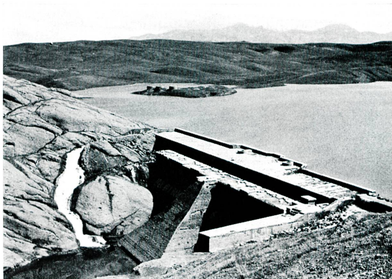
Bild 10 Aufgelöste Staumauer Fehrman.
