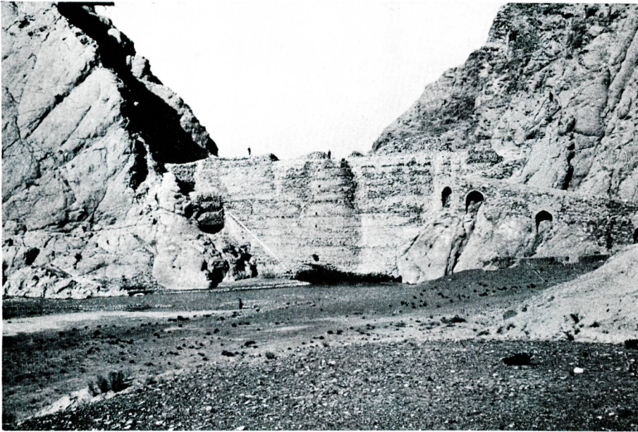
Bild 2 Gewichtsstaumauer bei Saveh von oberstrom mit dem eingebauten Entnahmeturm.
