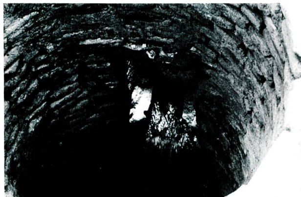
Bild 14 Eine Schützöffnung im Entnahmeturm der Gulestan-Sperre.
