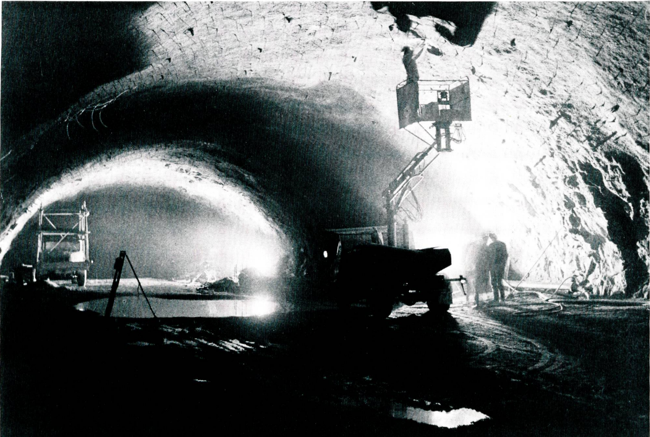
Bild 16 Felsausbruch der Kalotte für das Kavernenkraftwerk Wehr
