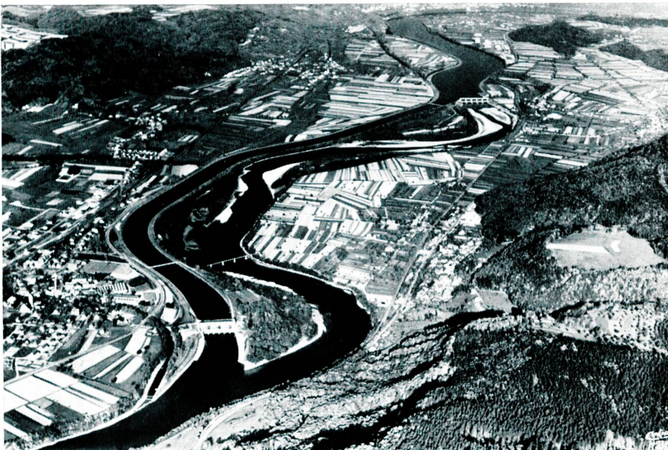
Bild 7 Rheinkraftwerk Albrück-Dogern; einziges Kanalkraftwerk am Hochrhein
