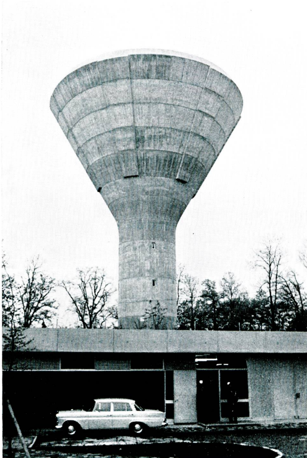
Wasserturm Salonwald in Ludwigsburg (Foto G. A. Töndury)
