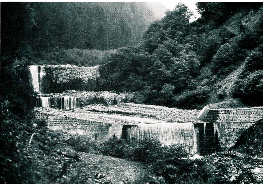
Bild 3 Neuere Sperre in der Nolla. Der Seitendruck vom linken Hang wird durch den verkleideten Damm aufgenommen.
