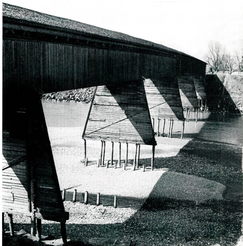
Bild 32 Rhein bei km 54,4 mit Holzbrücke Haag—Bendern, die im Jahre 1867/68 erbaut wurde. Die Sohlenvertiefung der letzten Jahre ist gut sichtbar.
