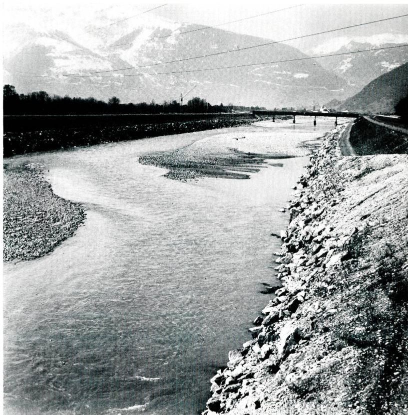
Bild 31 Rhein bei km 36,6 mit Holzbrücke Trübbach—Balzers, die im Jahre 1870/71 erbaut wurde.
