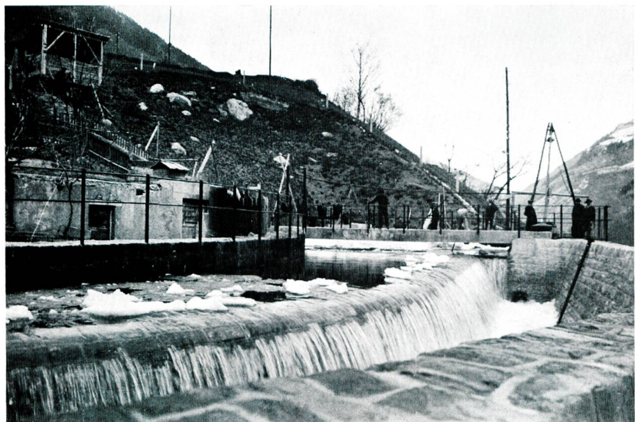
Bild 6 Chemische Messungen (Verdünnungsverfahren): Mittels Kochsalz, im Kraftwerk Massaboden der SBB, im Jahre 1915.
