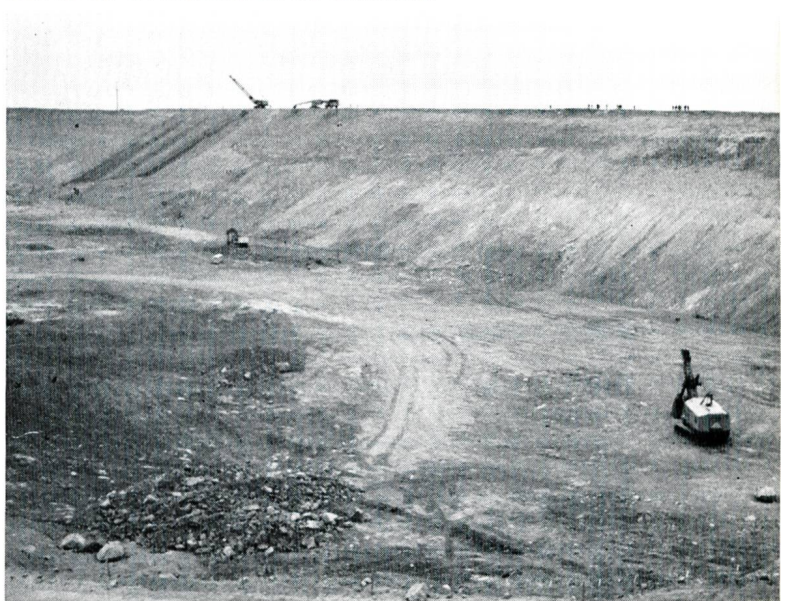
Bild 4 Teilansicht des oberen, rund vier Mio m 3 fassenden Pumpspeicherbeckens der Hornbergstufe. Hinsichtlich der Dimensionen beachte man die Menschen auf der Dammkrone.
