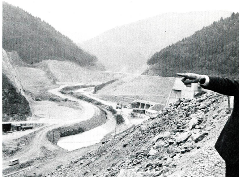
Bild 3 Blick in die Baugrube des Wehrbeckens der Hornbergstufe für die Pumpspeicheranlage des Hotzenwaldwerks der Schluchseewerk AG.
