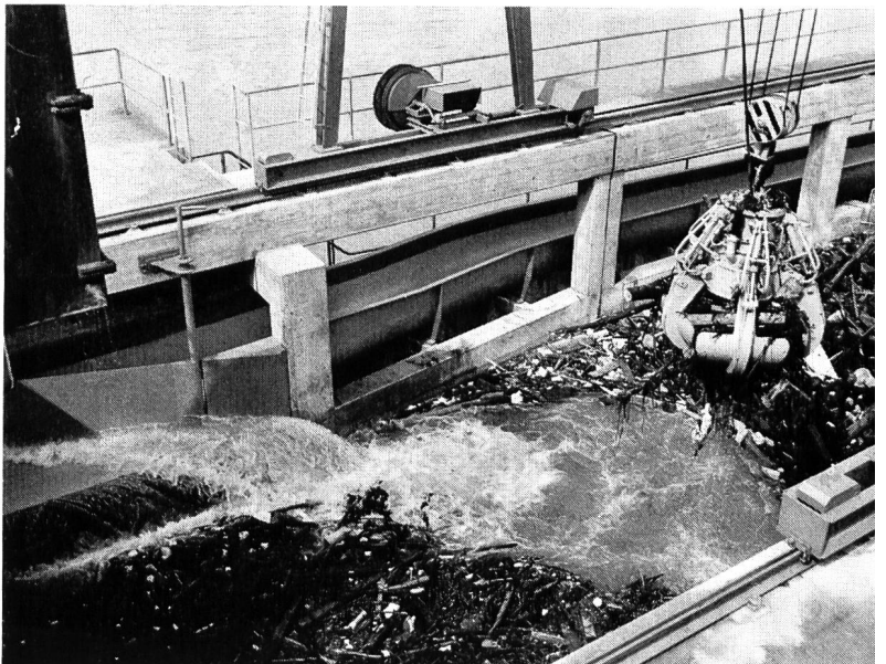
Bild 4 Blick in das Becken mit dem Mehrschalengreifer des Bockkranes.
