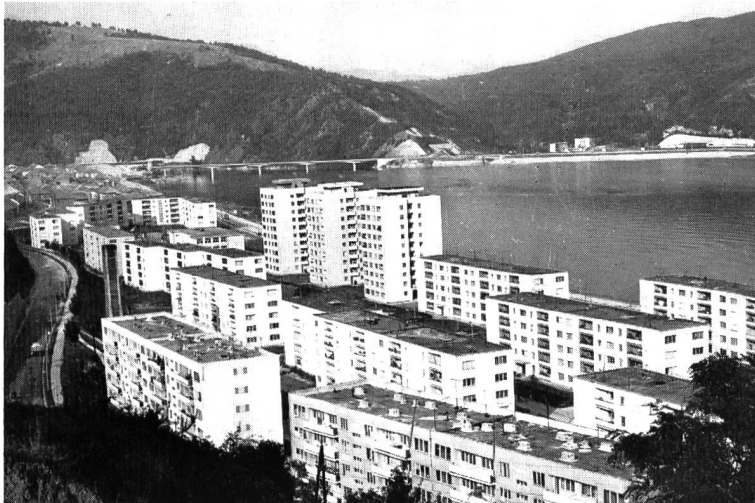
Bild 3 Teilansicht der neuen Stadt Orschowa am rumänischen Donauufer; im Hintergrund einer der zahlreichen Viadukte.
