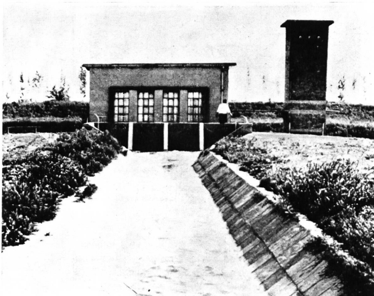
Bild 5 Blick auf eine der vielen ähnlichen Pumpstationen.
