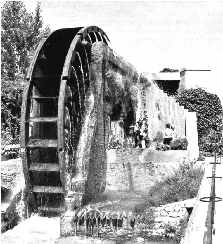
Bild 7 Noria in Alcantarilla südwestlich von Murcia in Südost-Spanien.
