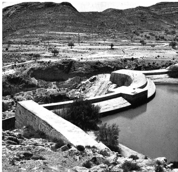
Bild 12 Die 1632 in Angriff genommene Bogenstaumauer Elche südwestlich von Alicante, von ihrem linken Widerlager aus (Höhe 23 m, Gesamtlänge 120 m).
