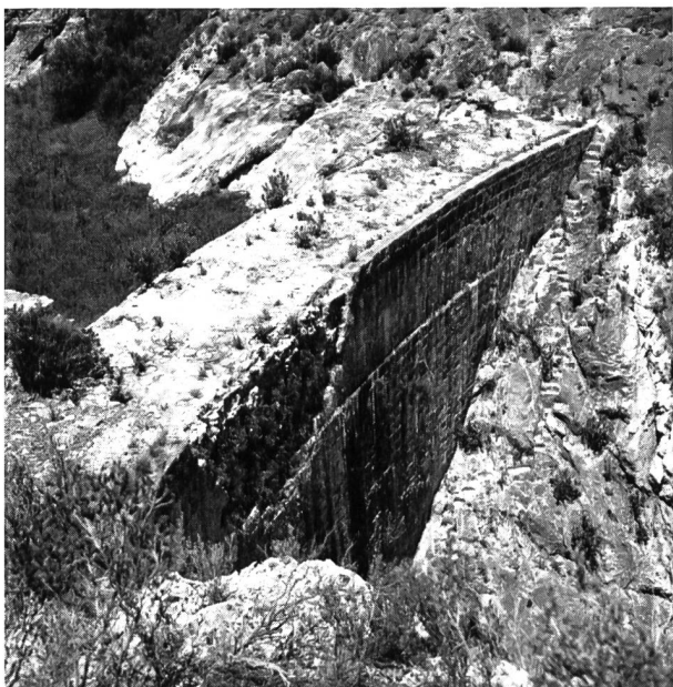
Bild 15 Die aus dem 17. Jahrhundert stammende Staumauer Relleu nördlich von Alicante; auf der Höhe des untern Randes des Verkleidungsschadens erkennt man die Ansatzlinie der Erhöhung von 1879 (Höhe 32 m, Länge 41 m).
