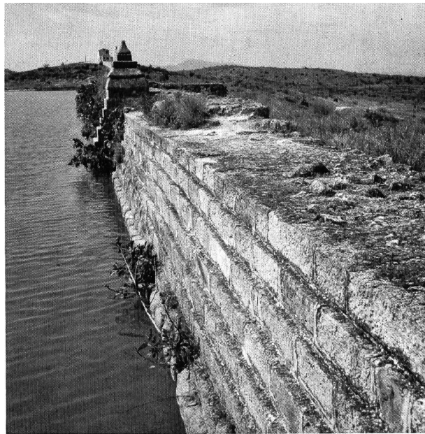
Bild 4 Wasserseite des römischen Erddammes Proserpina nördlich von Merida mit vorspringendem Stützpfiler, dessen Aufsatz aus dem 17. Jahrhundert stammt (Höhe 12 m, Länge 427 m).
