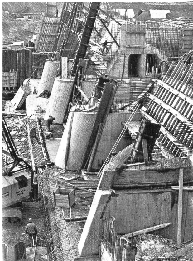
Bild 4 Kraftwerk Bremgarten-Zufikon, Baustadium anfangs 1973.
