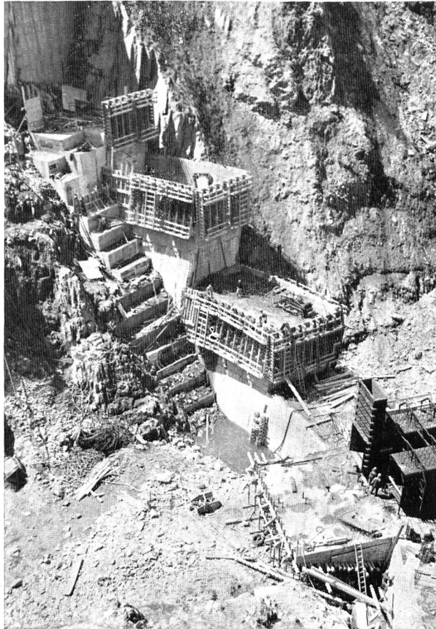
Bild 10 Staumauer Ferden, Bauzustand im Mai 1974.
