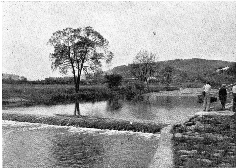
Bild 2 Wasserfassung an der oberen Donau für den Umleitungsstollen Immendingen-Möhringen.
