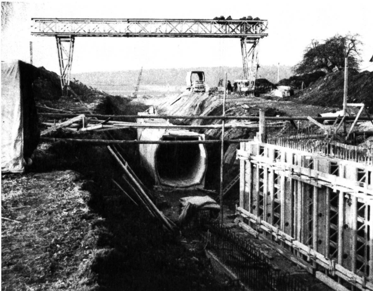
Bild 14 Verbandssammler Singen-Ramsen, Ausführung mit vorfabrizierten Elementen.
