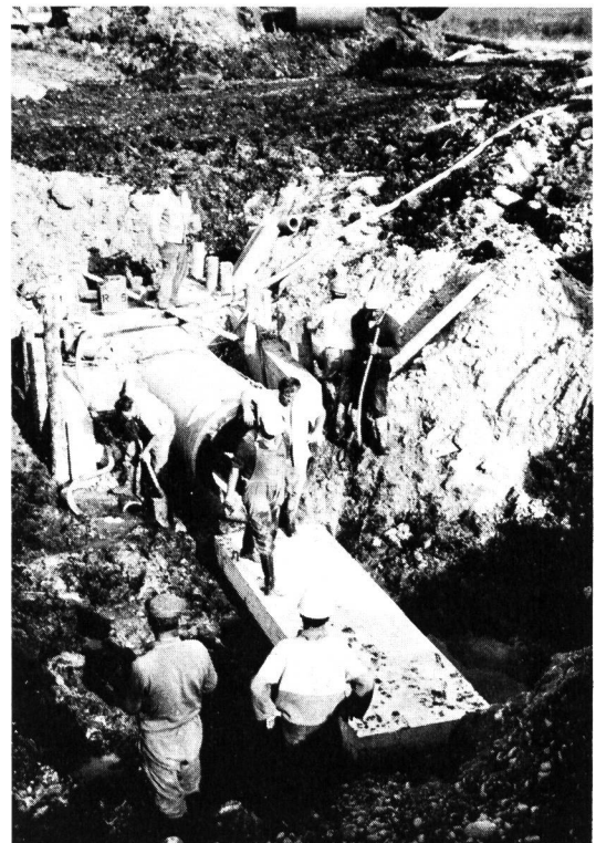
Bild 12 Pfahl-Platten-Gründung des Bibertal-Hauptsammlers.
