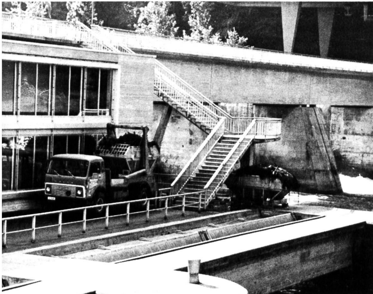
Bild 9 Kraftwerk Schaffhausen: Umlad und Abfuhr des Rechengutes.
