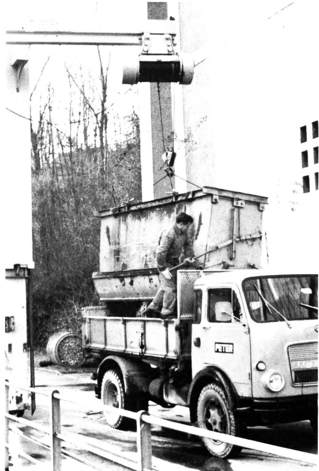
Bild 11 Kraftwerk Rheinau: Entleerung der Rechengut-Mulde auf Lastwagen.
