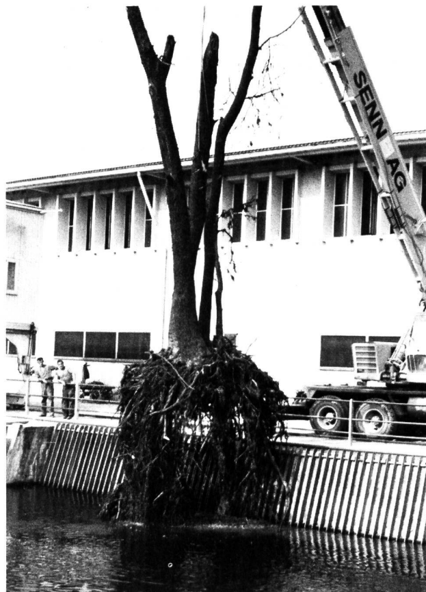
Bild 1 Kraftwerk Wildegg-Brugg: Beispiel von «Grobgeschwemmsel».
