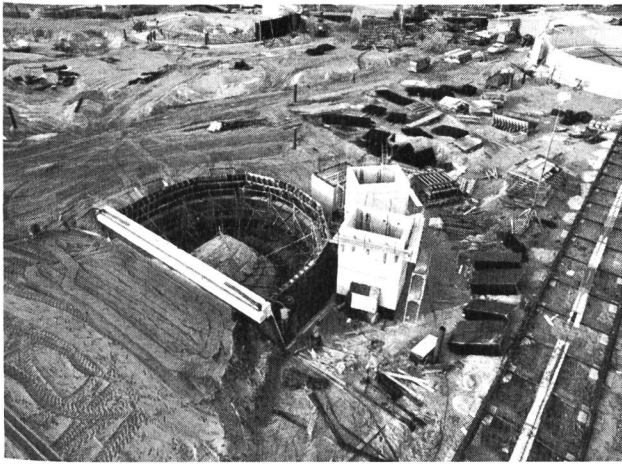
Bild 4 Einlaufbauwerk. In der Mitte, deutlich erkennbar, der riesige Betonkegel, über den das ankommende Abwasser in die Verteiler geleitet wird.
