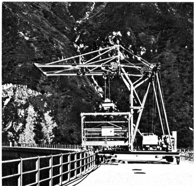
Bild 4 Kranähnliche Vorrichtung auf der Dammkrone
